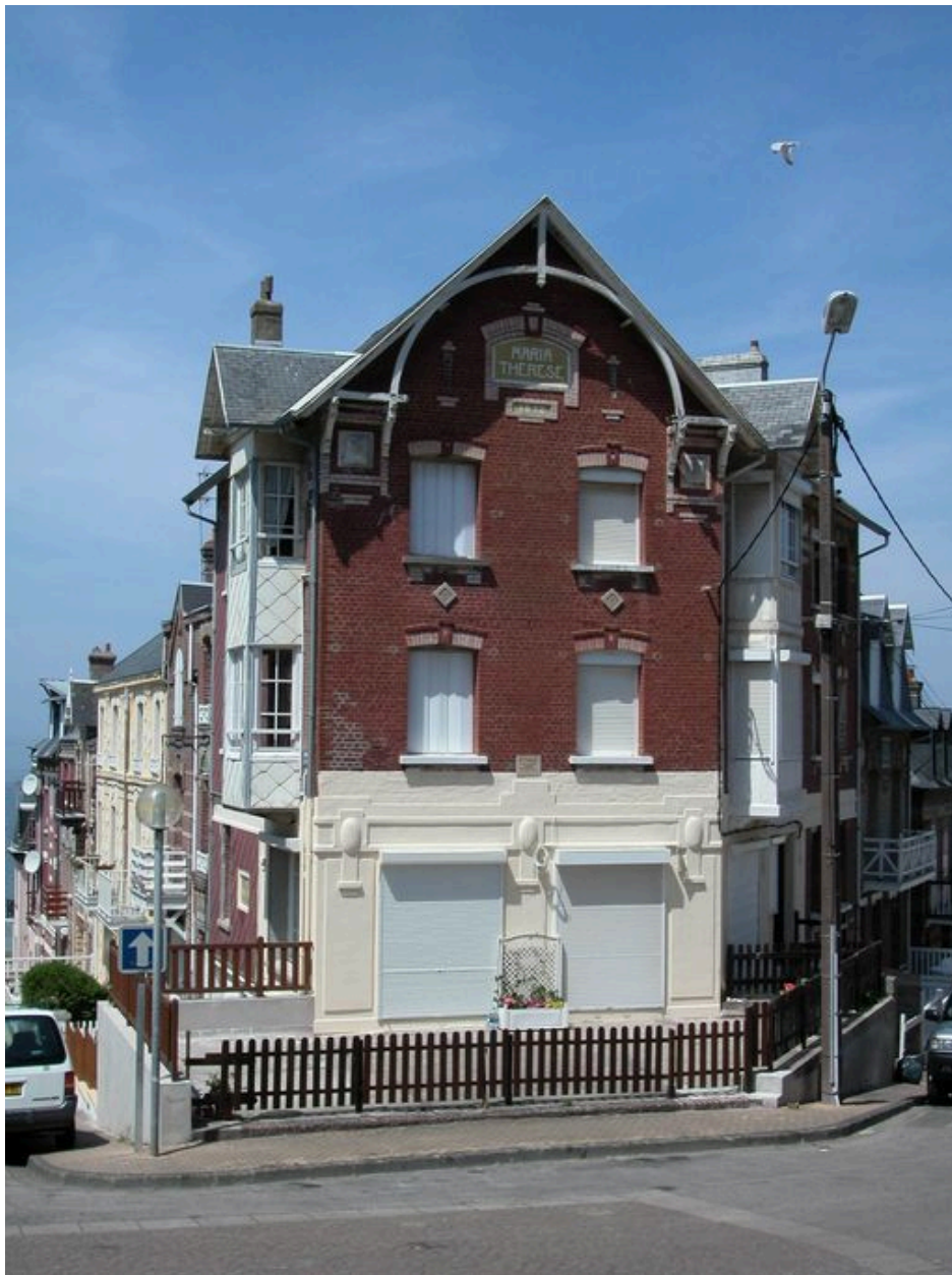
Vue d'ensemble depuis la place du Maréchal-de-Lattre-de-Tassigny.
