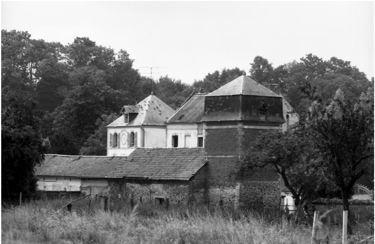
Vue d'ensemble des bâtiments, depuis le nord.
