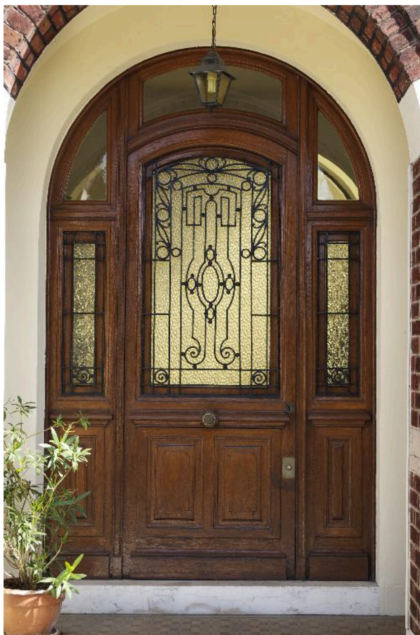
Porte d'entrée principale, détail.
