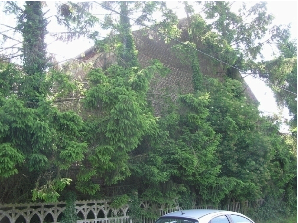
Vue d'un pignon de la grange.
