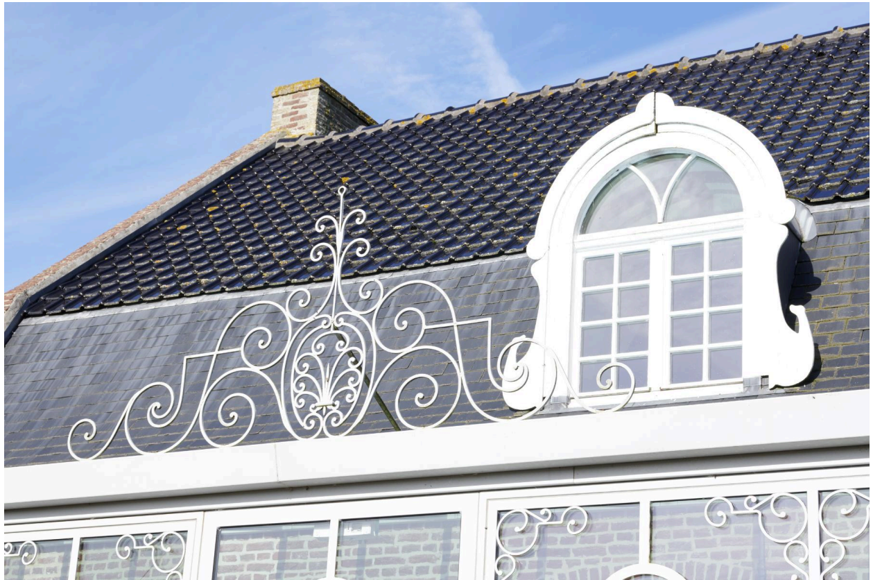
Détail de la lucarne principale et des ferronneries de la verrière.
