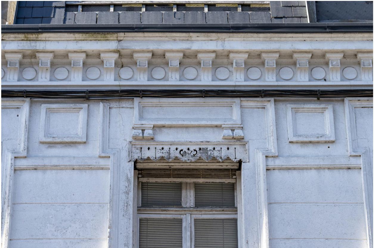
Détail du décor de tables affleurées et de la corniche sommitale soutenant le chéneau.
