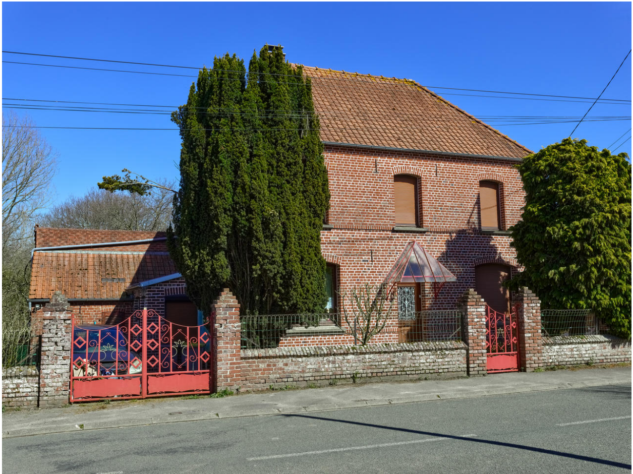
Maison en brique du début du XXe siècle, rue Haute.
