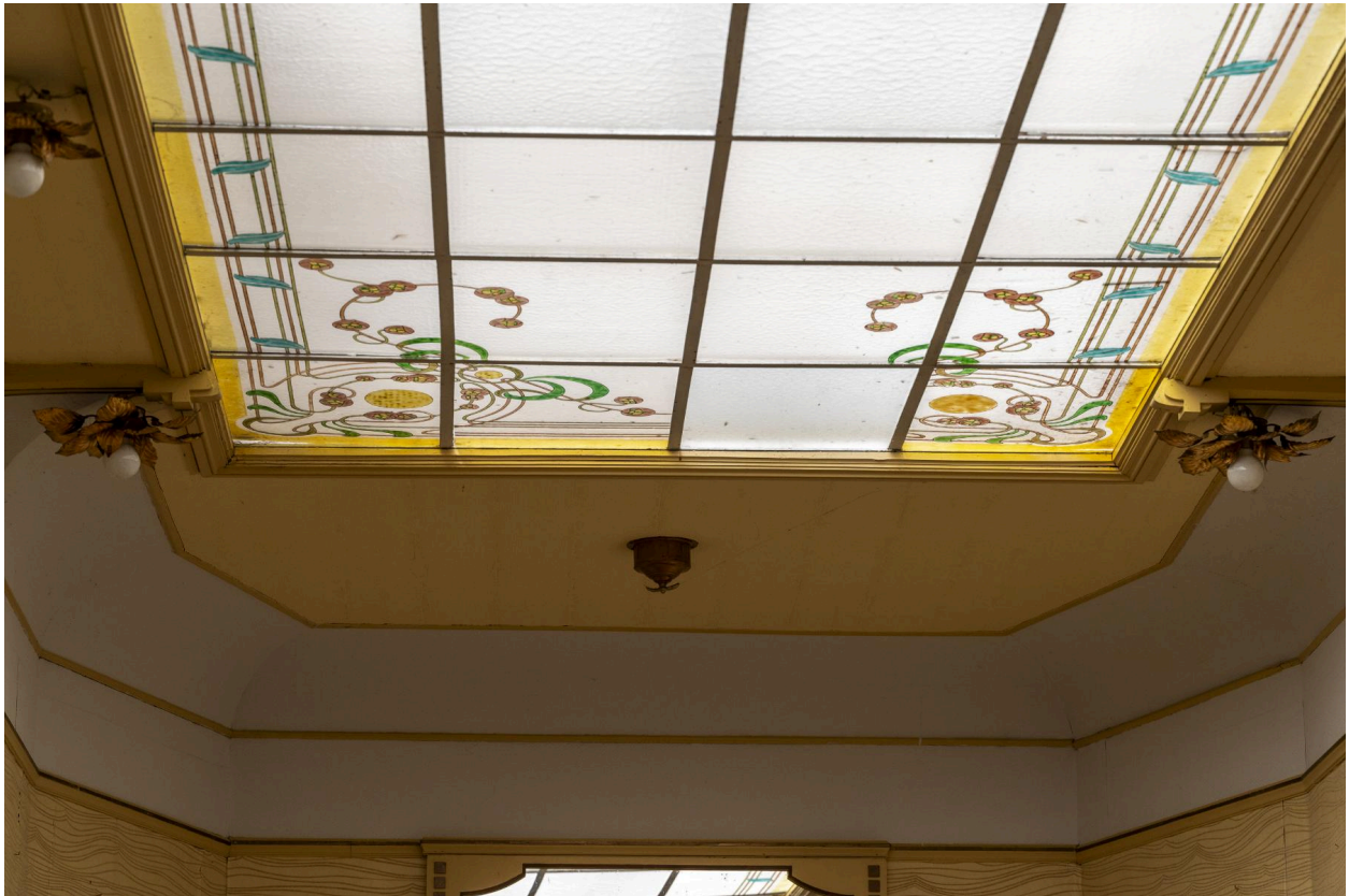
Détail de la verrière couvrant la salle à manger : motif des extrémités.
