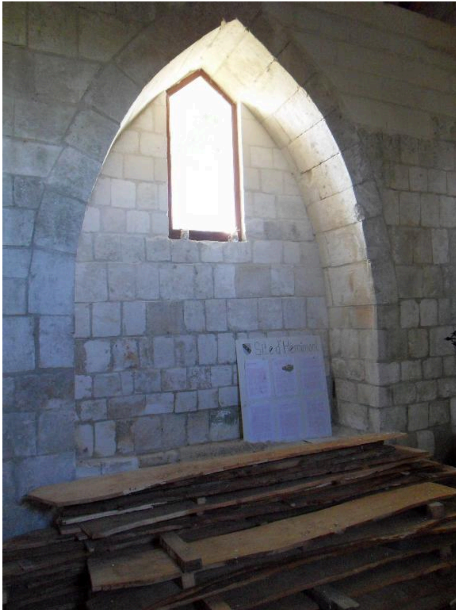
Vue intérieure. Première arcature (mur sud).
