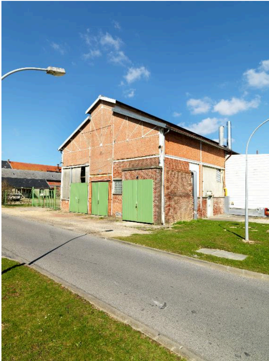
Ancienne centrale thermique, datée 1935.
