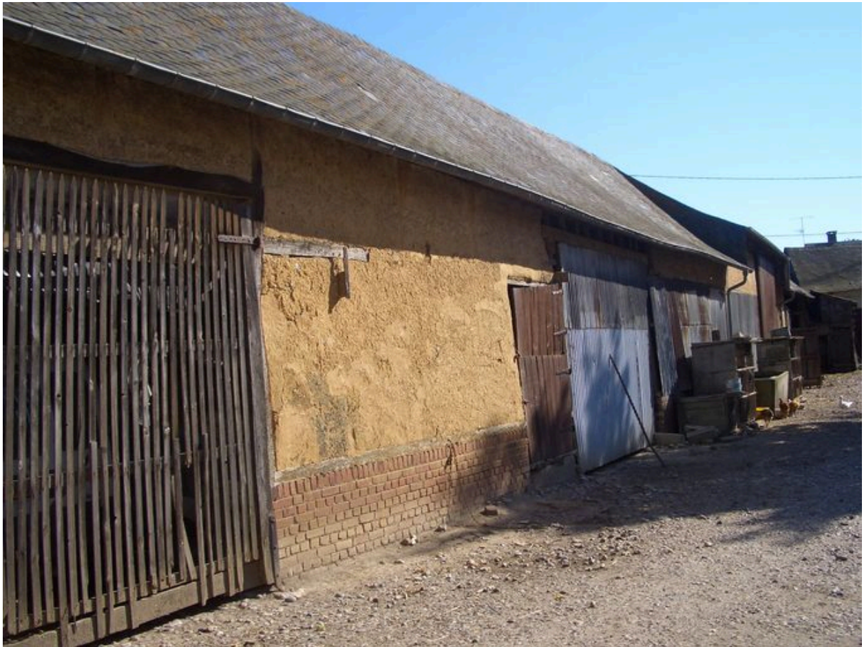
Vue de la partie sud de la grange.
