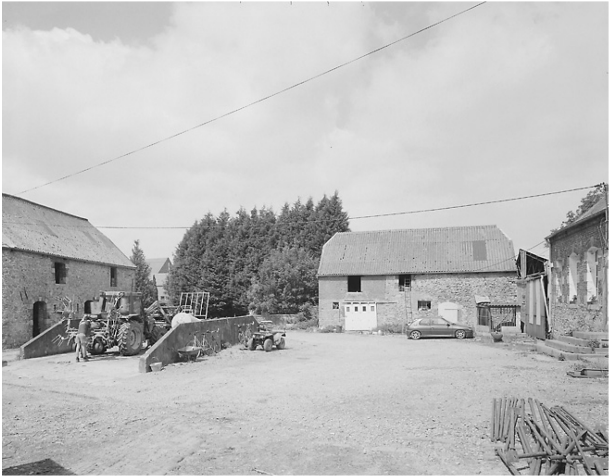
Vue des bâtiments d'exploitation.
