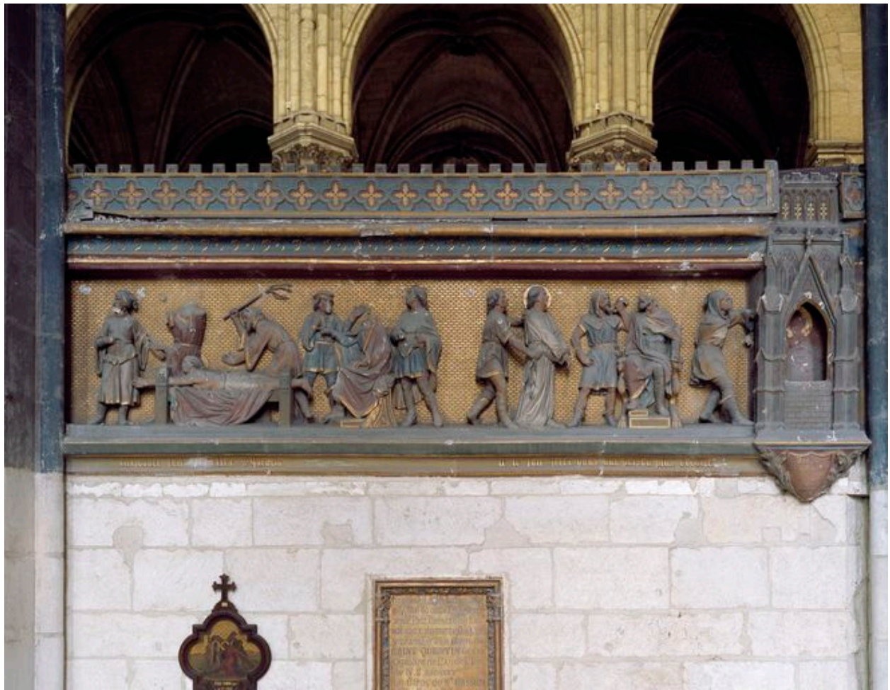
Vue de la troisième travée sud.
