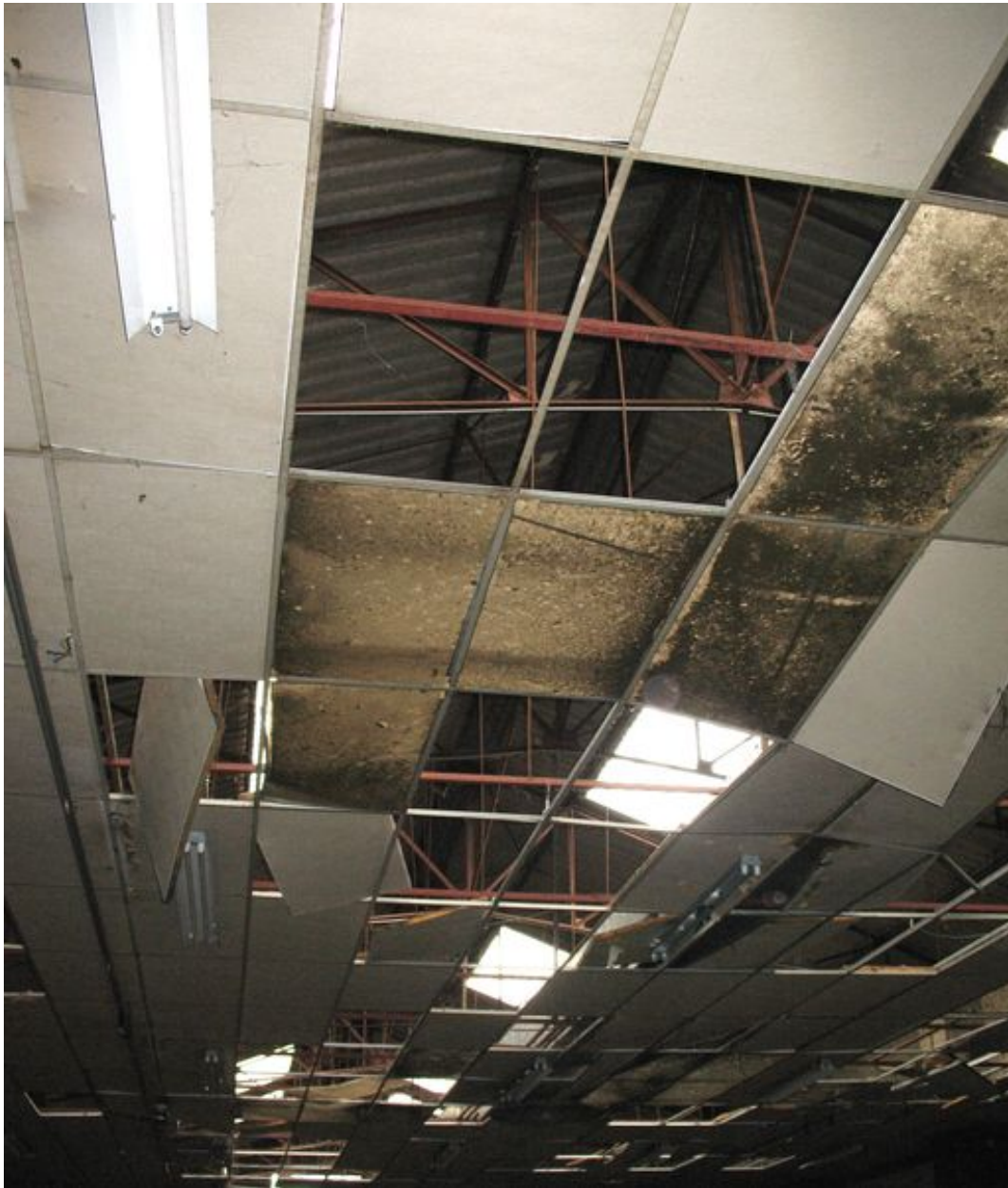
Le faux-plafond et la charpente métallique.
