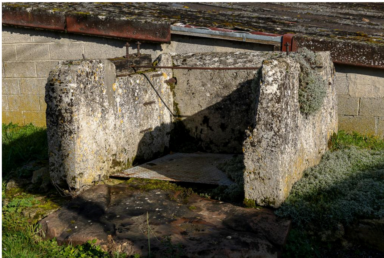
Anciens puits rue du Moulin.
