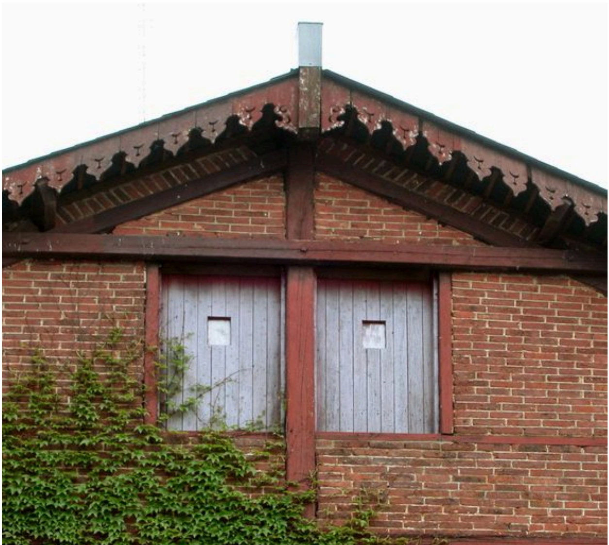
Détail des rives sculptés du pignon de l'atelier de conditionnement.
