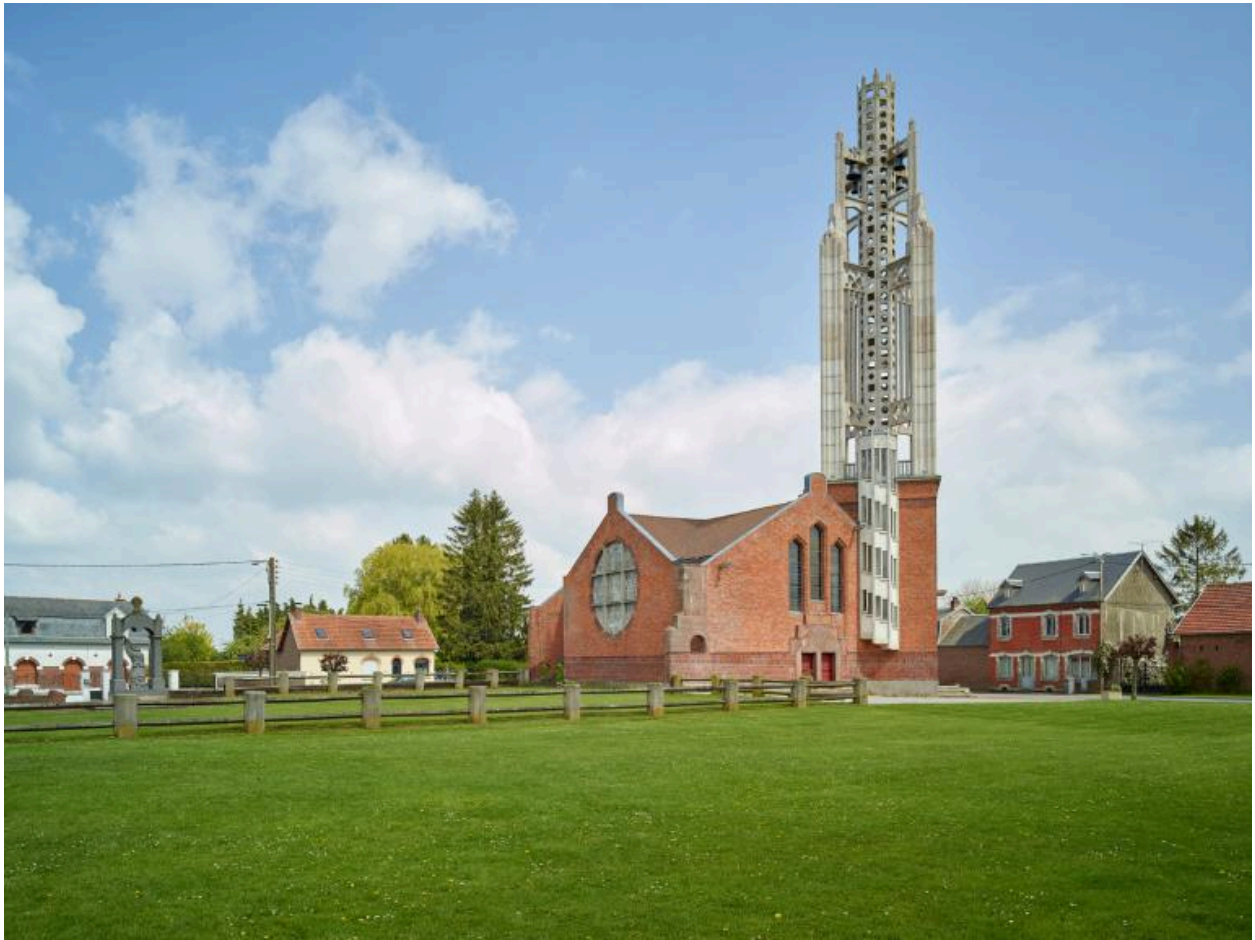
Vue de trois quarts vers le sud-est.
