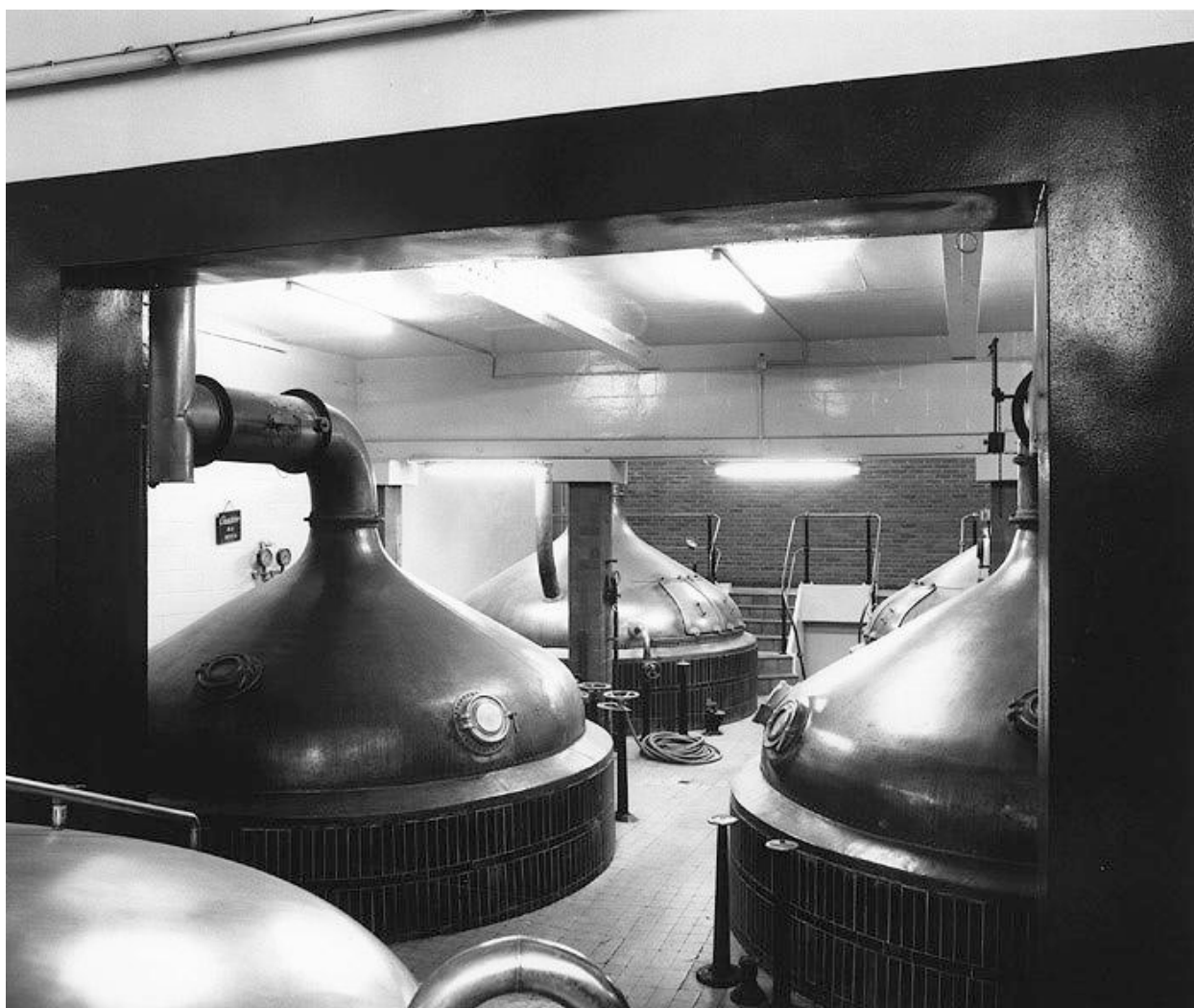
Salle de brassage, vue générale.
