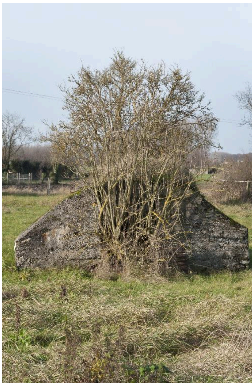
Casemate j, vers le nord-ouest
