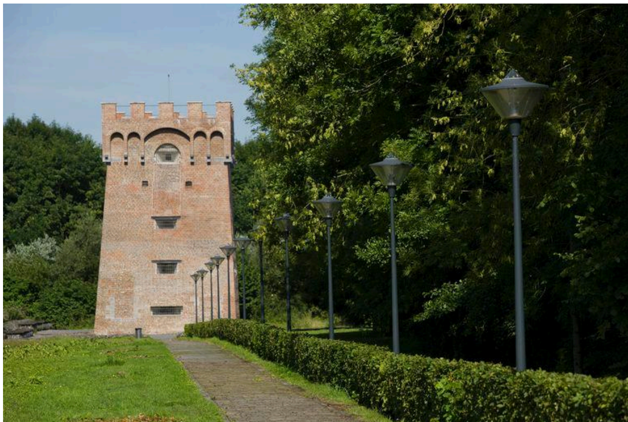
Chevalement du puits 1 de la fosse Sarteau, protégée au titre des Monuments Historiques.
