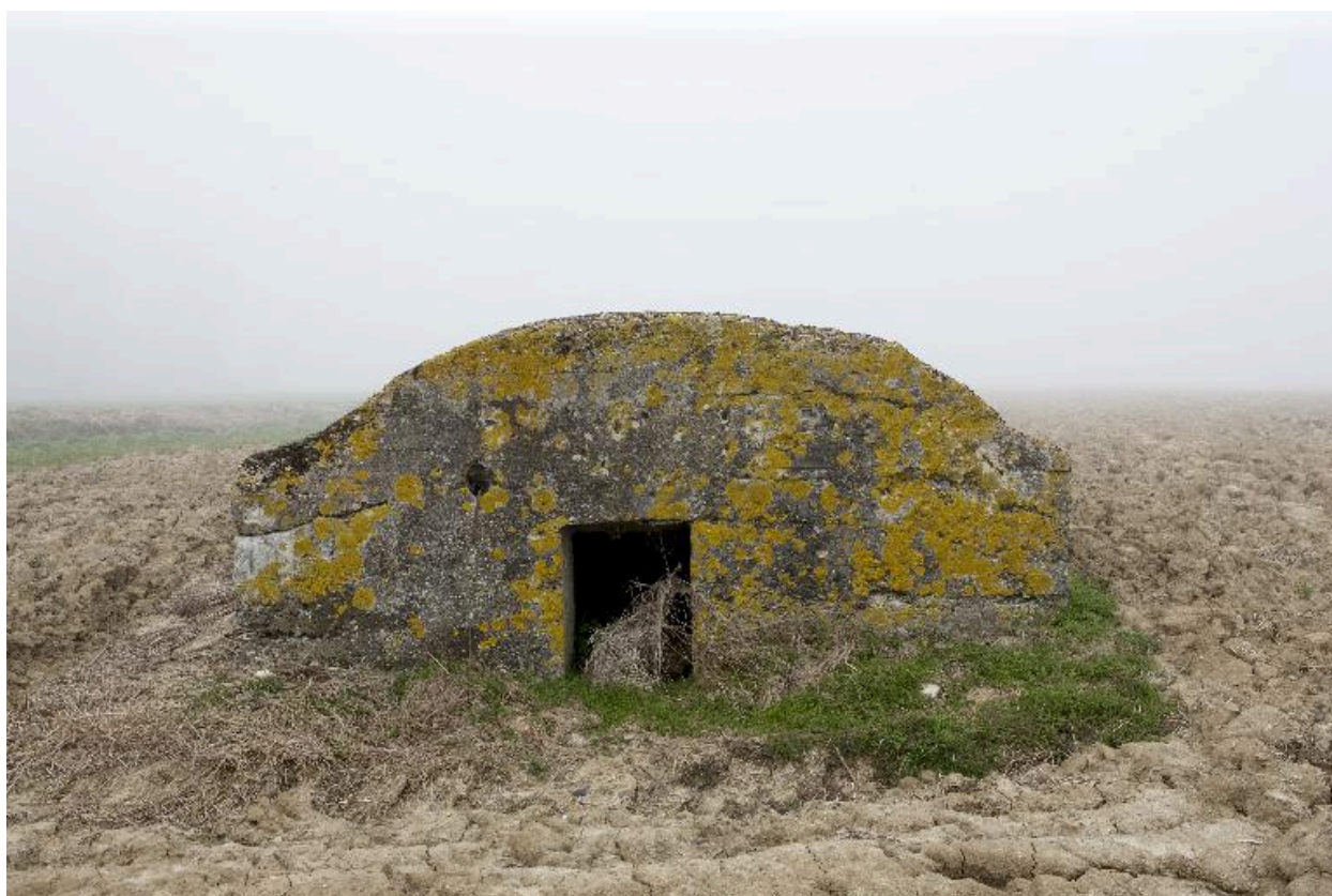
Pignon avec entrée, vers le nord-ouest
