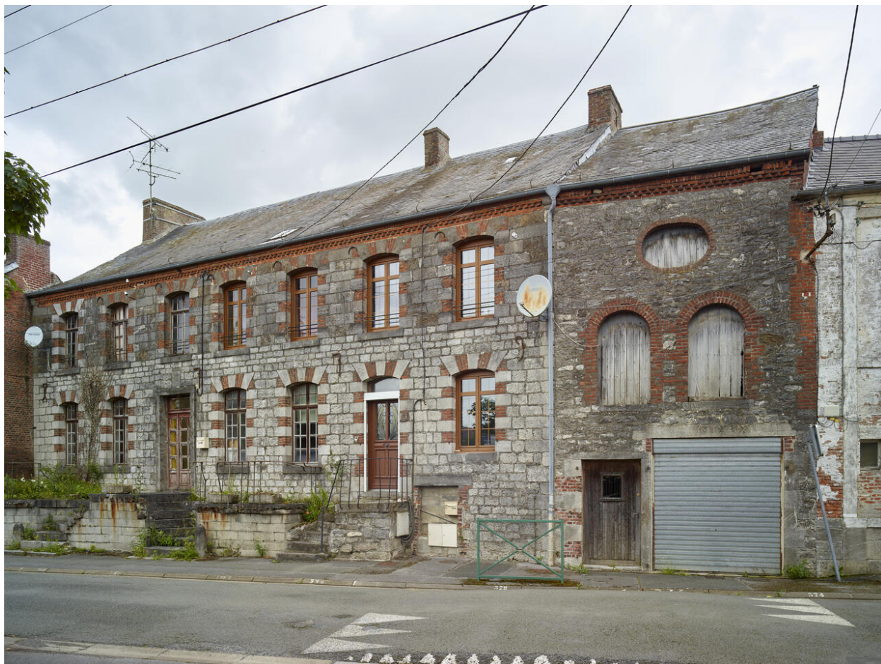
Logements des meuniers (?). Elévation rue du Moulin, vers le nord.
