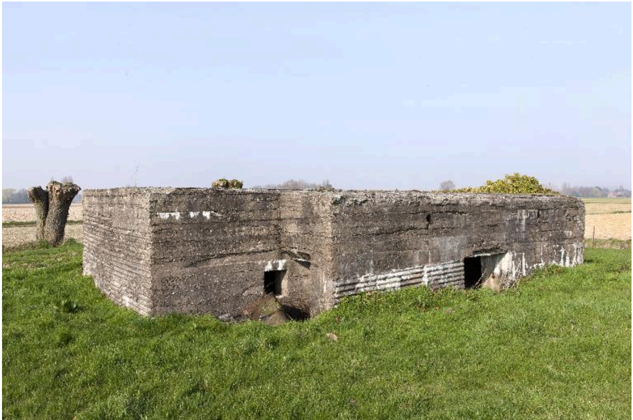
Elévation sud. Entrée ouest et sud du couloir de distribution intérieur
