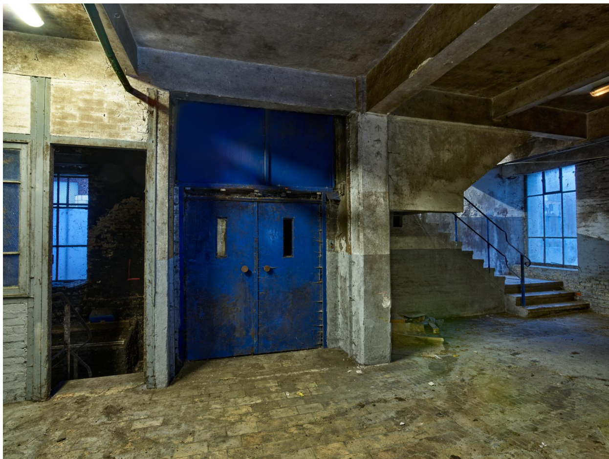
Bâtiment A, monte-charge depuis le rez-de-chaussée.
