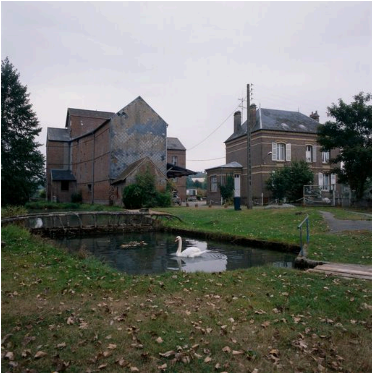
Vue générale de la minoterie et de son logement patronal.
