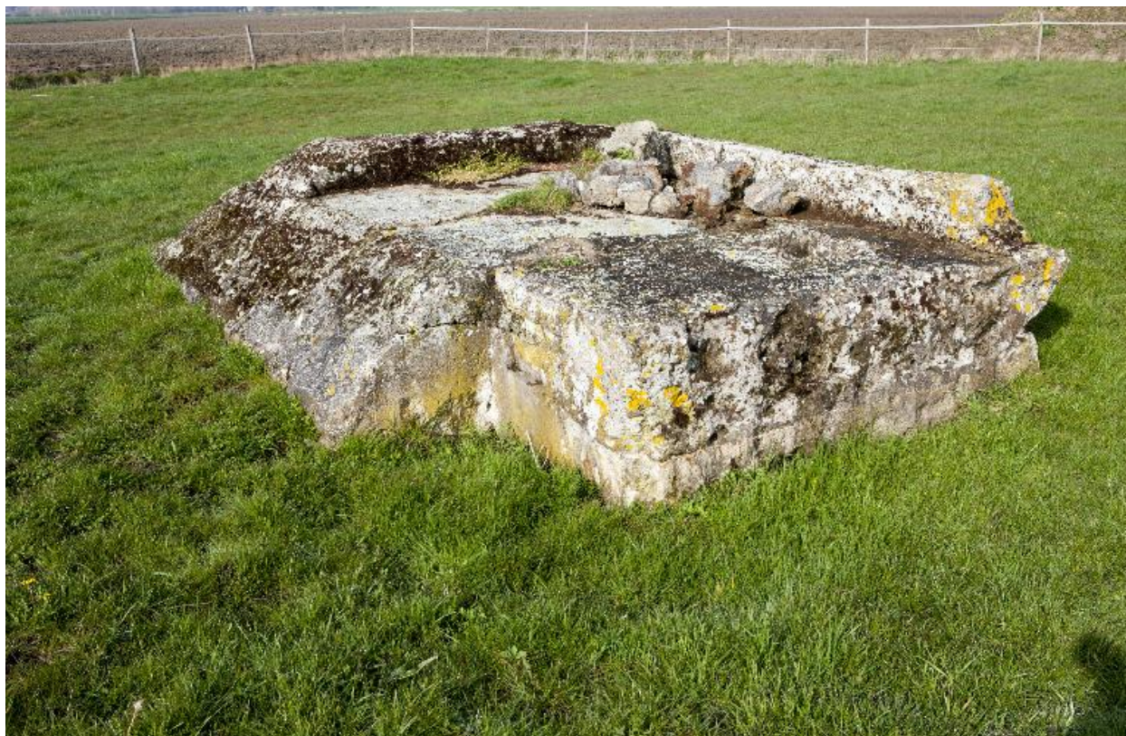
Casemate sud, vers le sud-ouest
