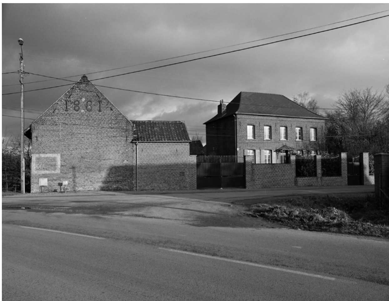
Ferme, 13 rue du Grand Rosult, vue générale.
