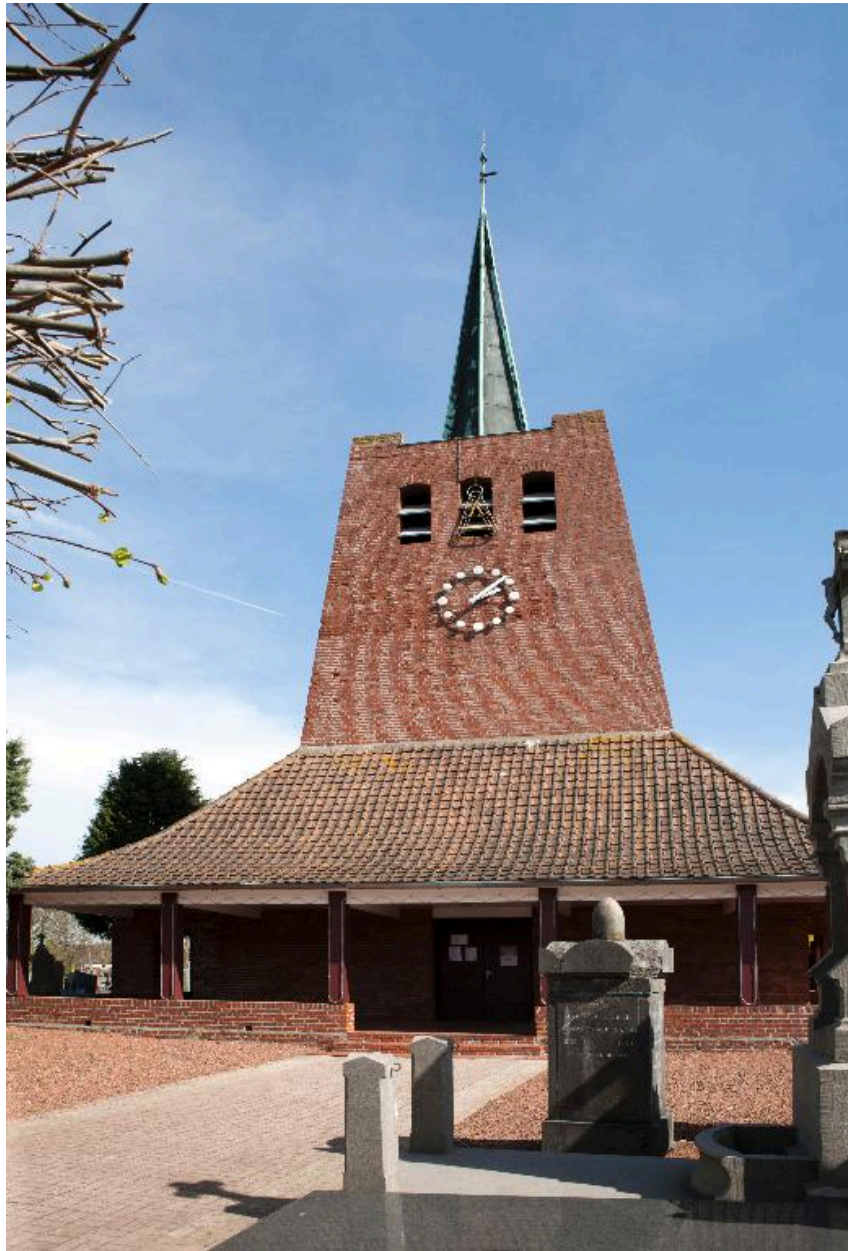
Vue de la façade occidentale.
