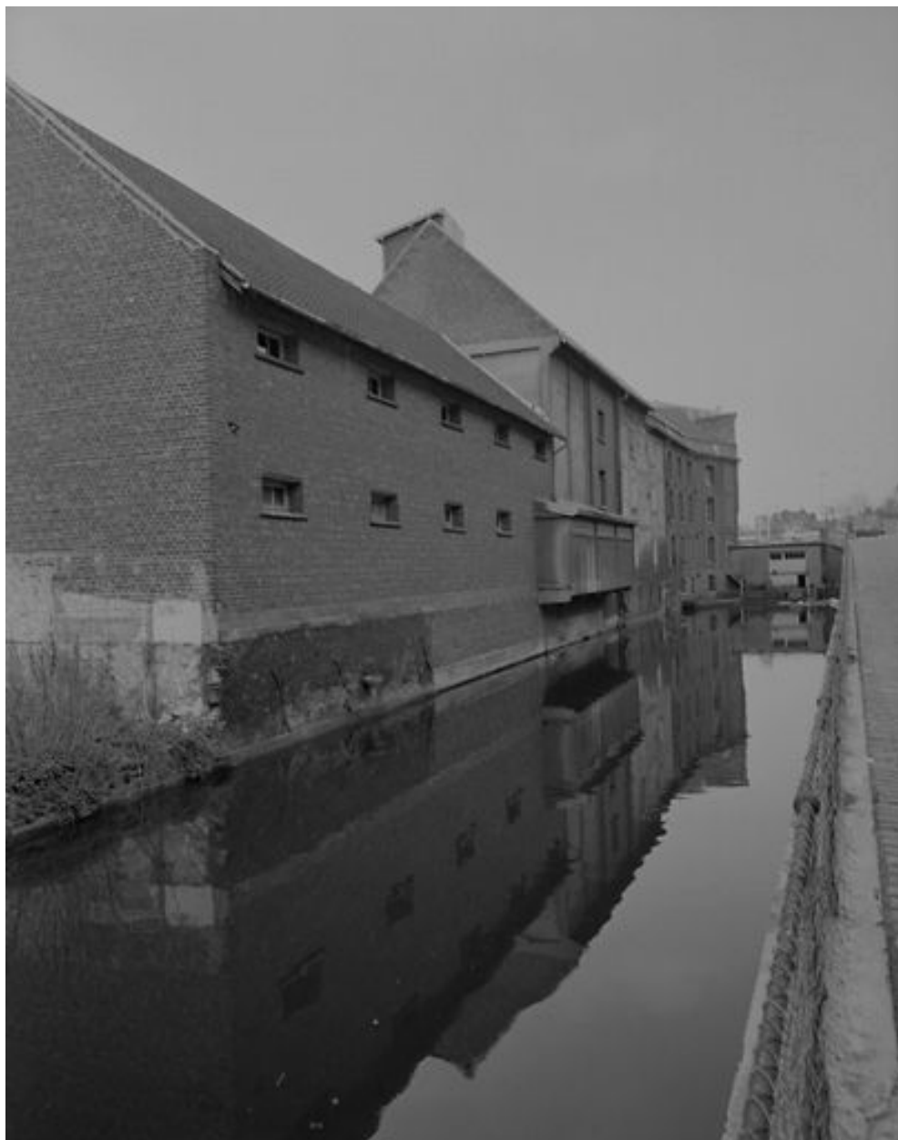
Vue générale, flanc nord.
