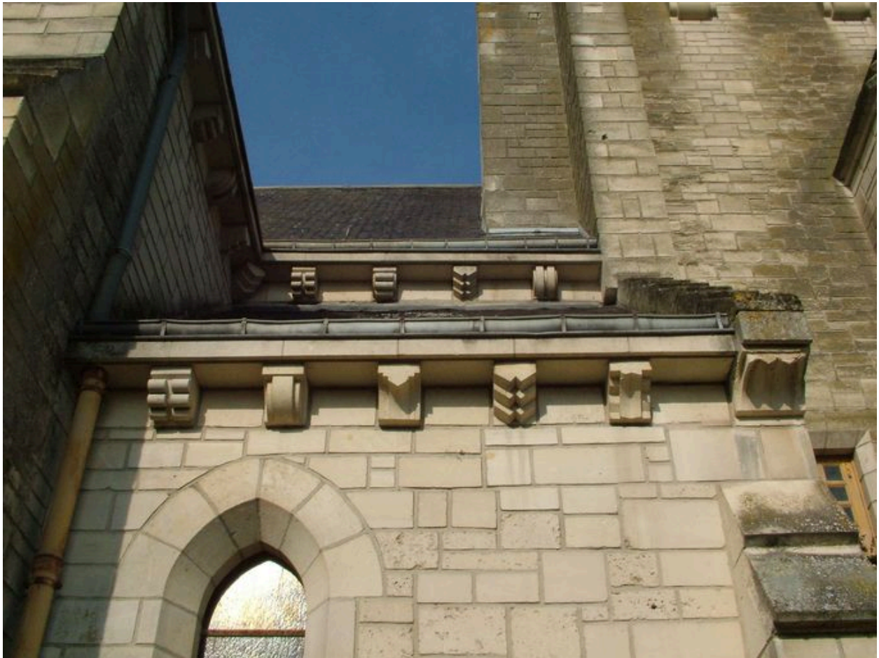
Détail des corbeaux à décor géométrique.
