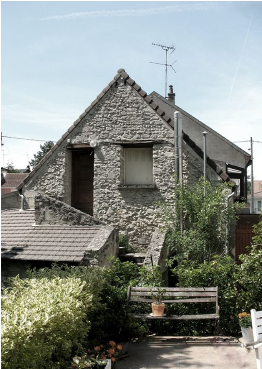
Mur pignon de l'ancienne distillerie.
