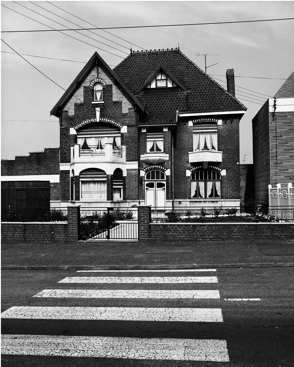
Vue générale de l'élévation antérieure.
