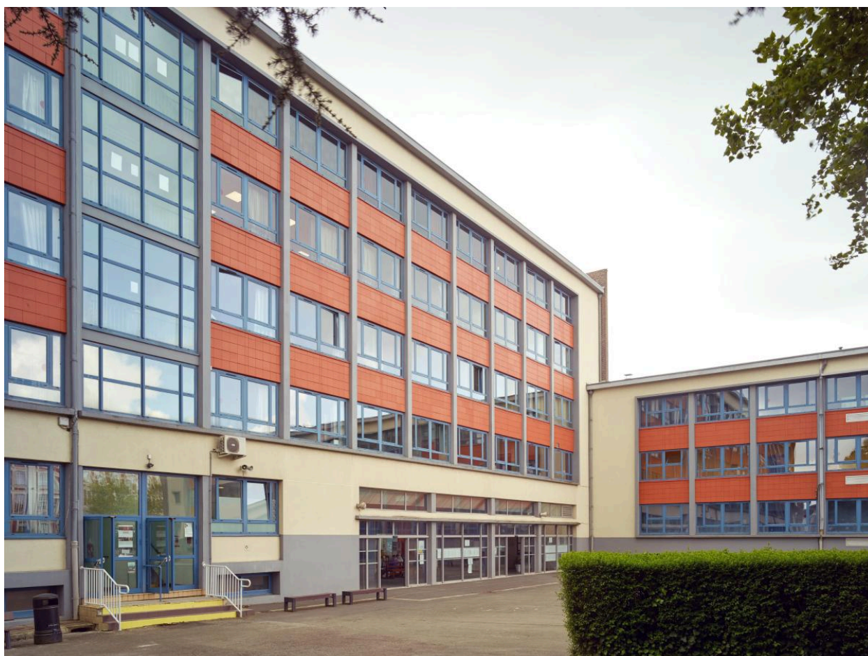
Externat et bâtiment des sciences : façades sur la cour des élèves.
