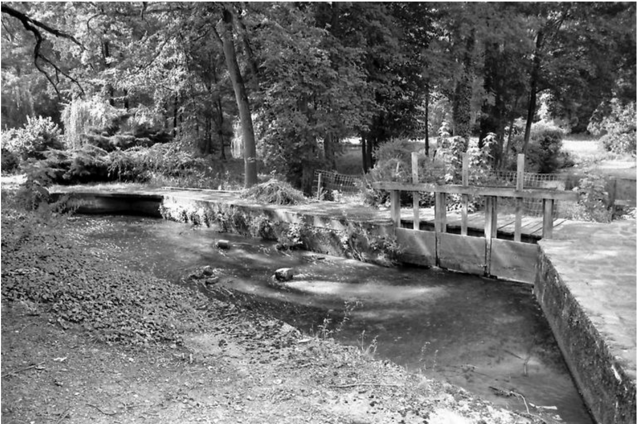
Vue du déversoir et des vannes du moulin.
