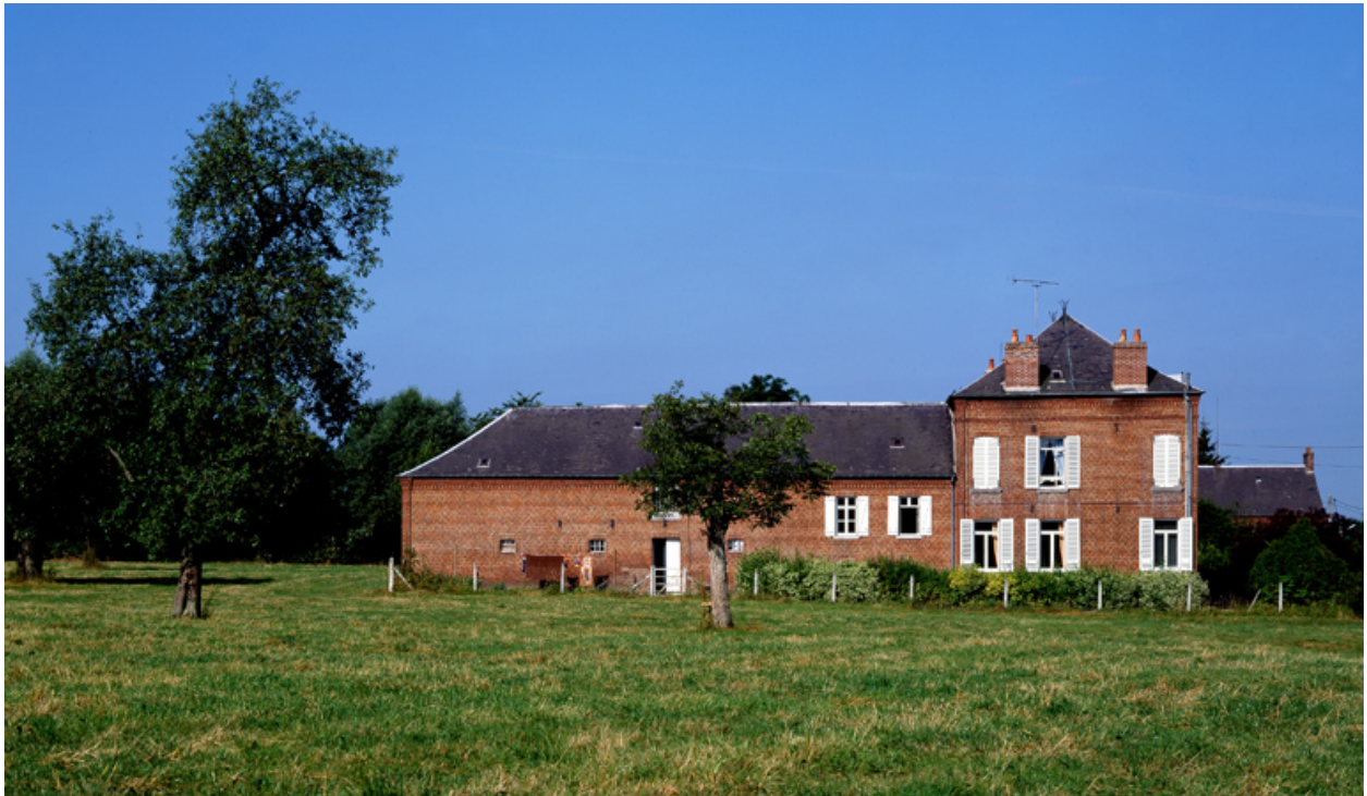
Vue de l'élévation est du logis et de l'étable attenante.
