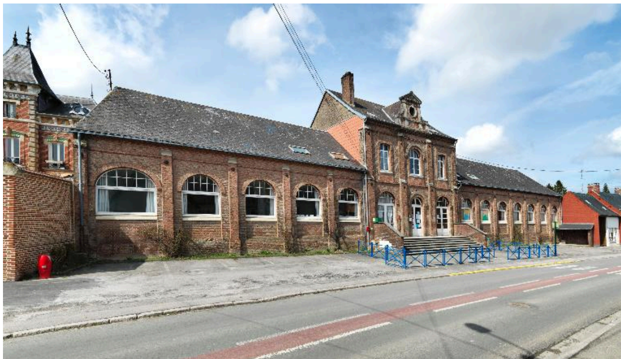
Vue d'ensemble sur rue.
