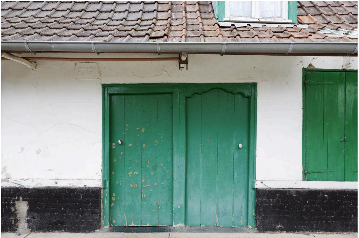
Détail de la façade sud.
