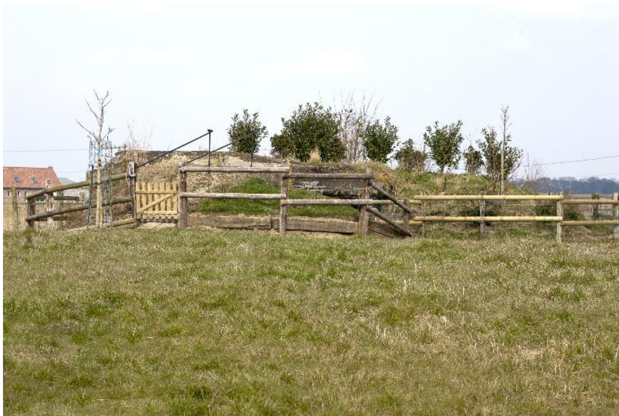
Vue générale, vers le nord-est
