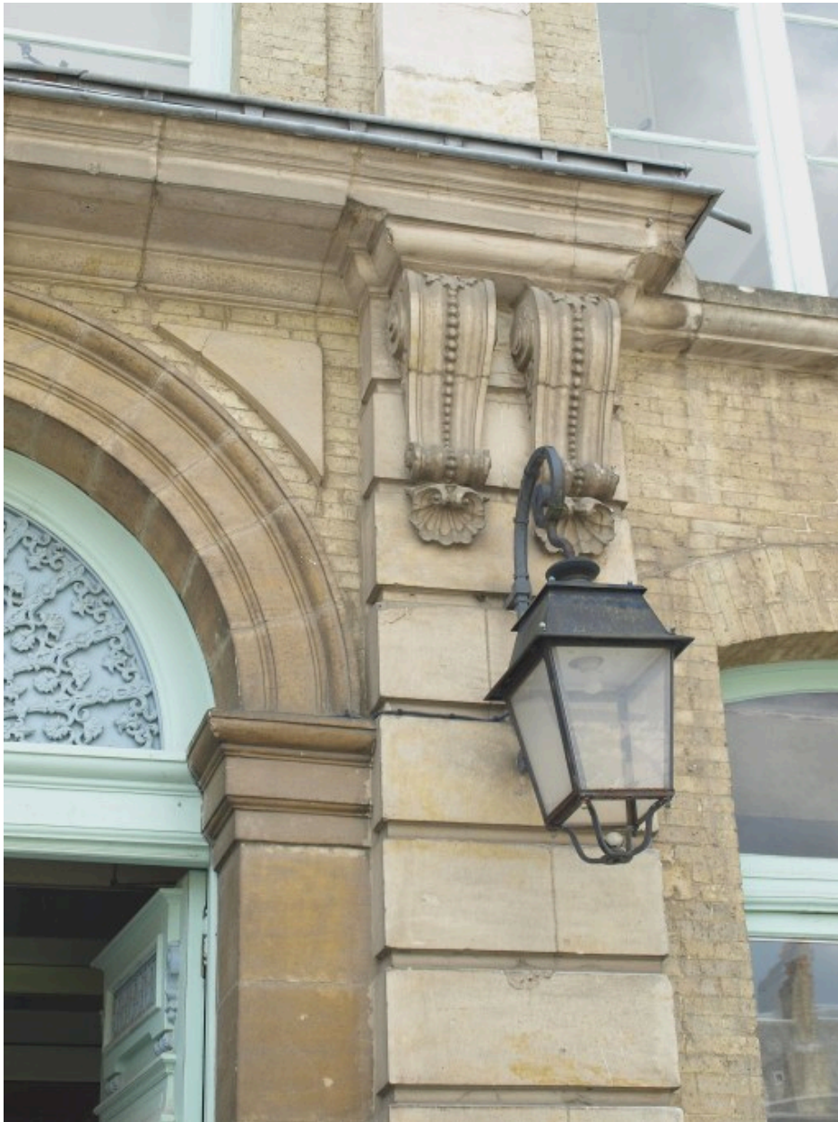
Détail sur la façade du bâtiment principal
