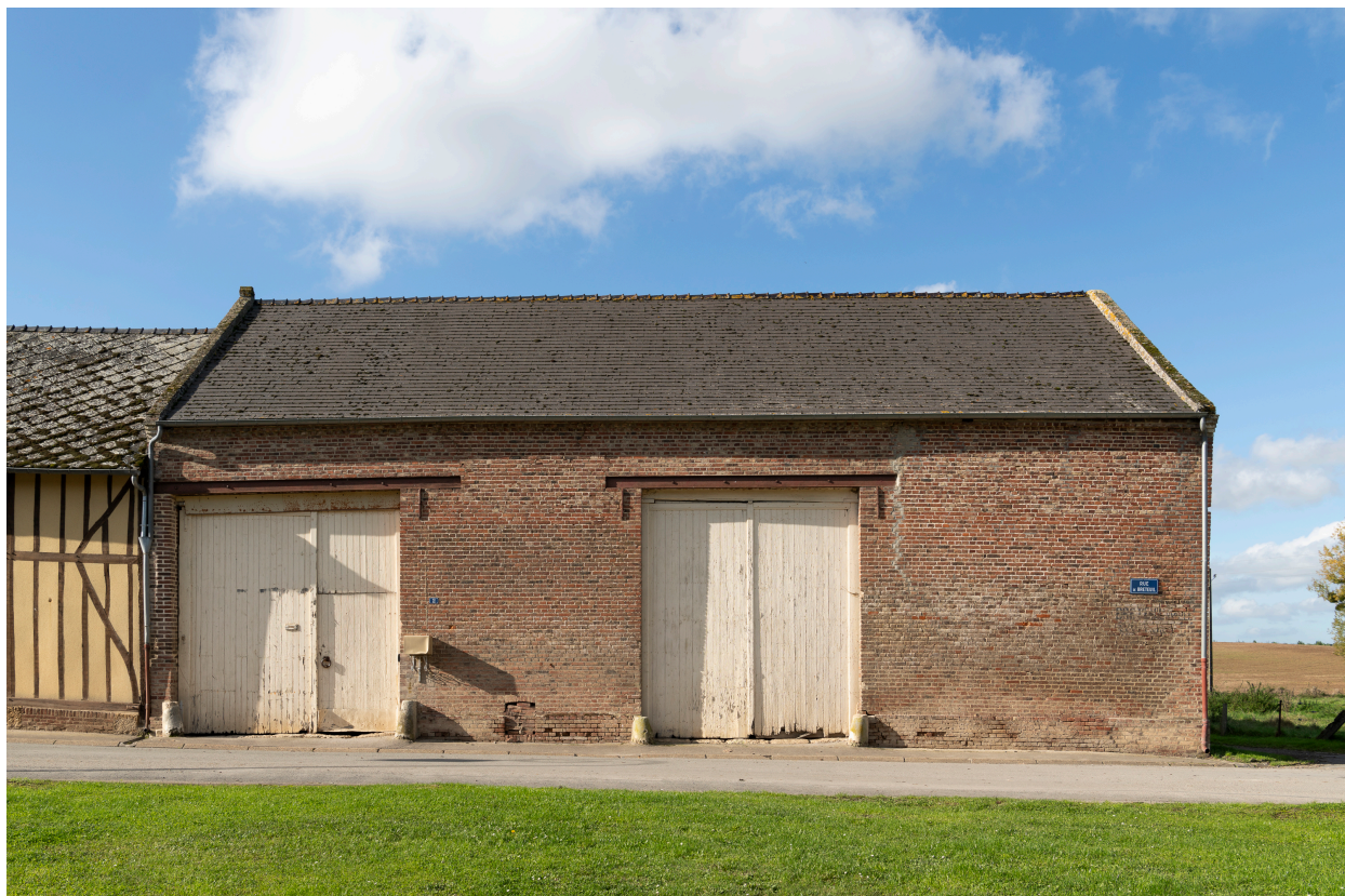
Grange en brique, n°2 de la rue de Breteuil, vue depuis l'est.
