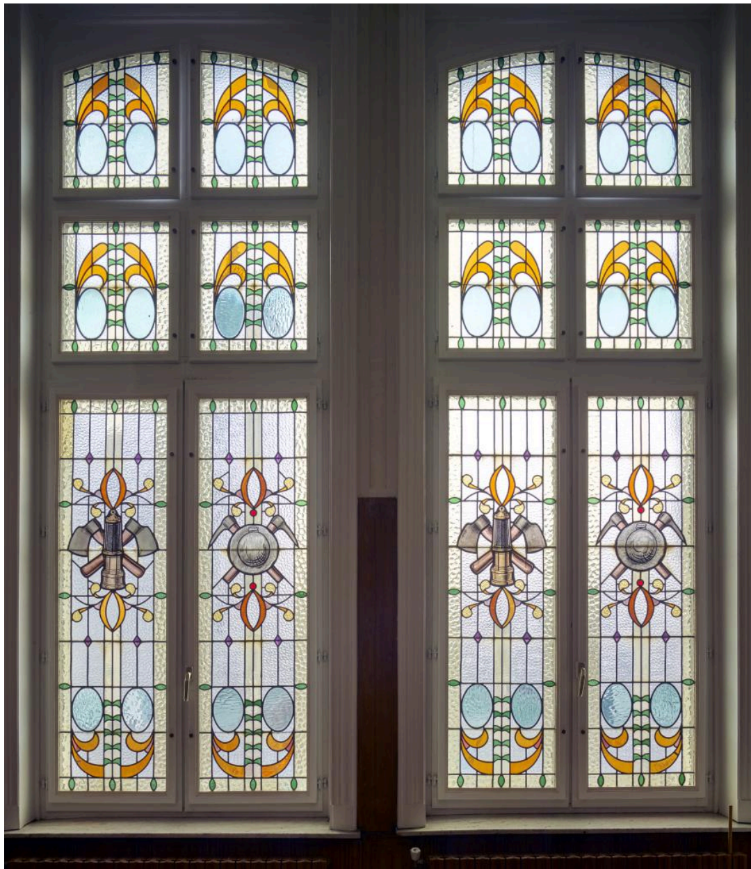
Salle des mariages, vue des deux verrières antérieures droites.
