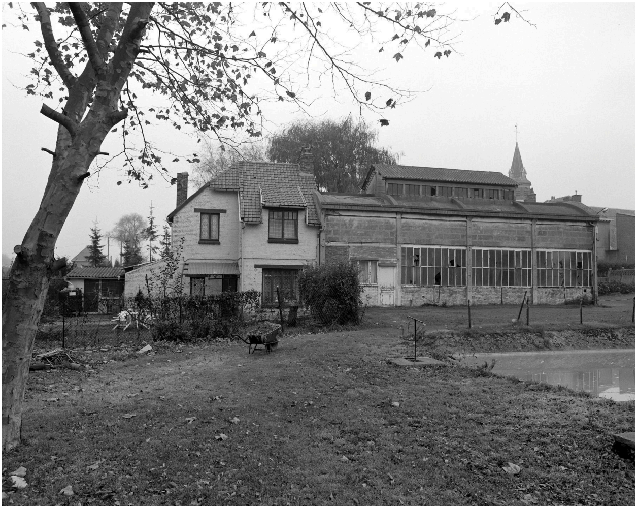
Hangar et habitations des mécaniciens. Vue prise vers le nord.
