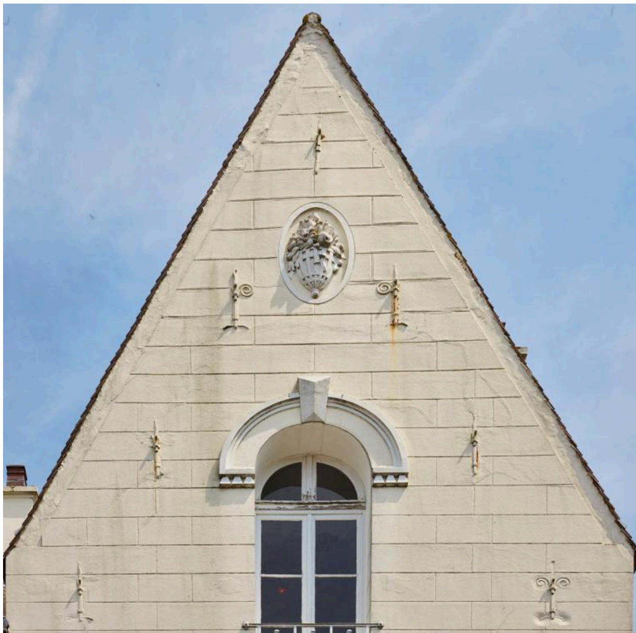
Maison, n° 36 rue Gambetta. Construite par Paul Decaux en 1928 pour Mme Legay-Carpentier (AD Pas de Calais, 10R9/109, dossier n°1745, 45J104 et 45J551.) Détail du pignon, enduit pour imiter la pierre et décoré d'un panier de fleurs en béton moulé.
