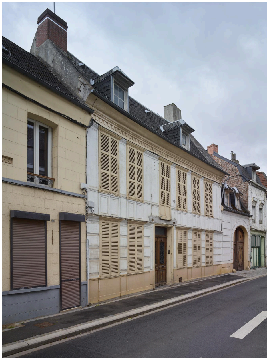
Maison de maître avec porte cochère et balcon (disparu en 2020) - 7, rue Nouvelle-Zélande.
