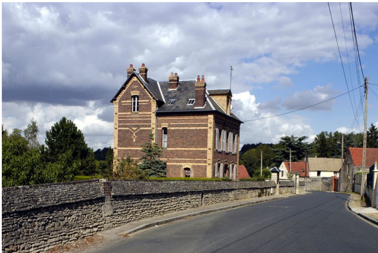
Le second logement patronal, vue d'ensemble.
