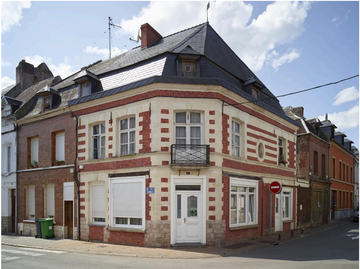
Maison de la première moitié du XVIII e siècle, avec façade en "rouge barre" faisant alterner lits de briques et lits de calcaire - 1, rue George-V.
