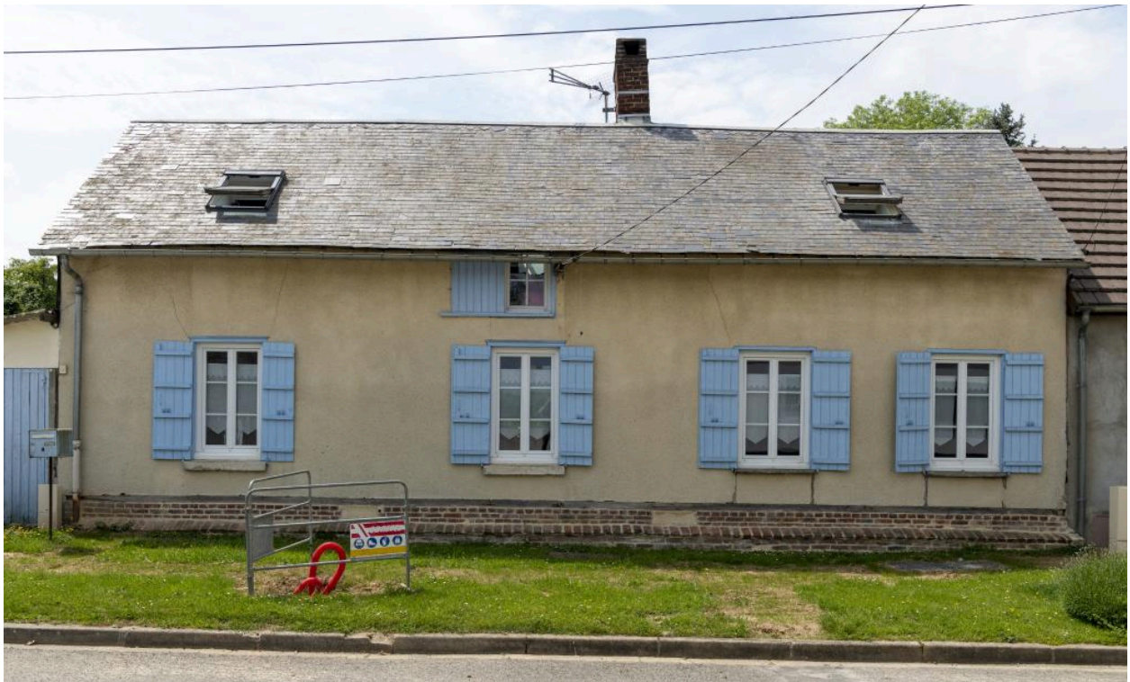
Logis sur rue, n°8 rue d'En-Bas, vue depuis l'est.
