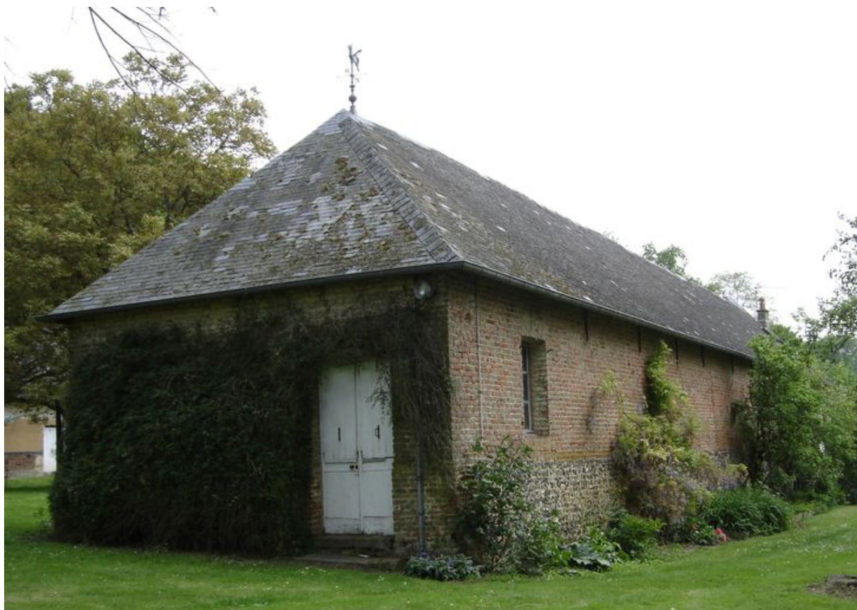
Vue postérieure de ce bâtiment.
