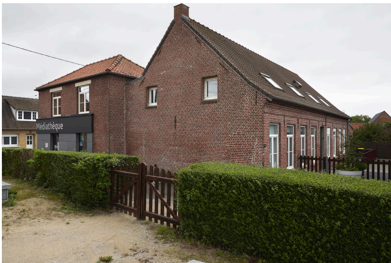
Pignon ouest et façade sud.
