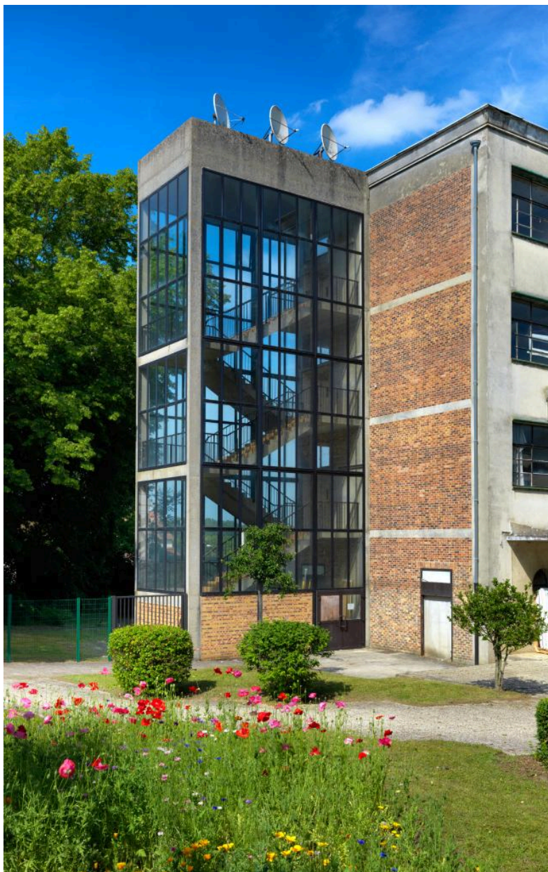
Cage d'escalier, vue extérieure.
